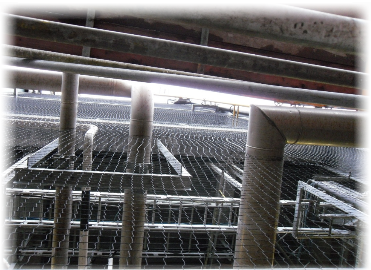
BOVEN EEN NET BIJ EEN CHEMISCH BEDRIJF WAAR ALLE LEIDINGEN NAADLOOS ZIJN INGEWERKT (INDUSTRIEEL NET), ONDER EEN NET VOOR EEN MONUMENTAAL PAND WAARBIJ DE ZICHTBAARHEID ONGEWENST WAS.
